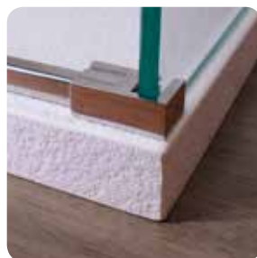
• Vierteaguas y remates metálicos
